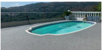
s'avère décisive pour garantir la durabilité du produit. Un filet de nylon est posé sur la dalle en béton pour éviter les micro fissures du marbre. Pour l'entretien, la simple application d'un vernis tous les deux ans suffit à préserver l'éclat de la pierre. Resiluxe propose à ses clients de personnaliser leurs abords de piscine avec un motif de leur choix, à l'aide d'un pochoir. Une tortue à deux têtes, une rose des vents, un dragon fantastique : toutes les créations sont possibles !
